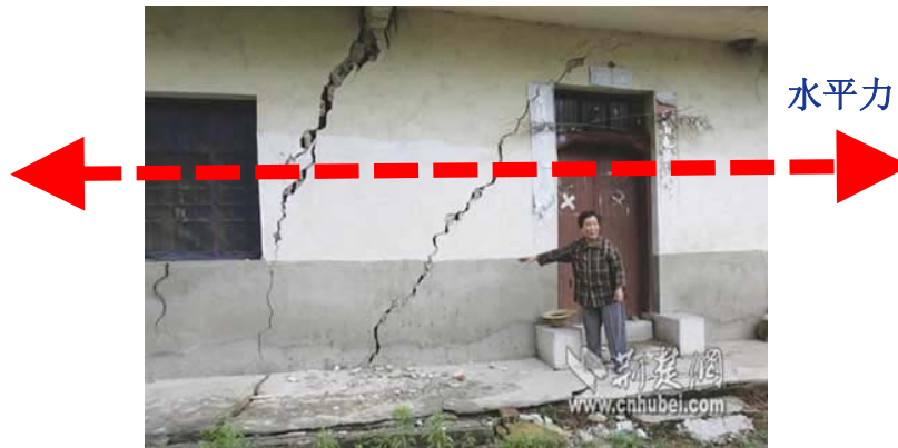
建筑物墙体的剪切破坏（地震后）
